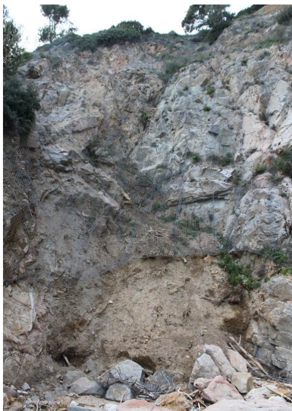
Fotografia 33. Detall d'esllavissada amb la base de la malla trencada.
