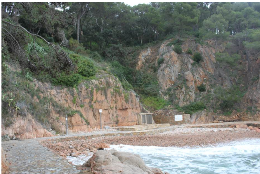
Fotografia 25. Cala d'Aiguadolça protegida amb malles.
