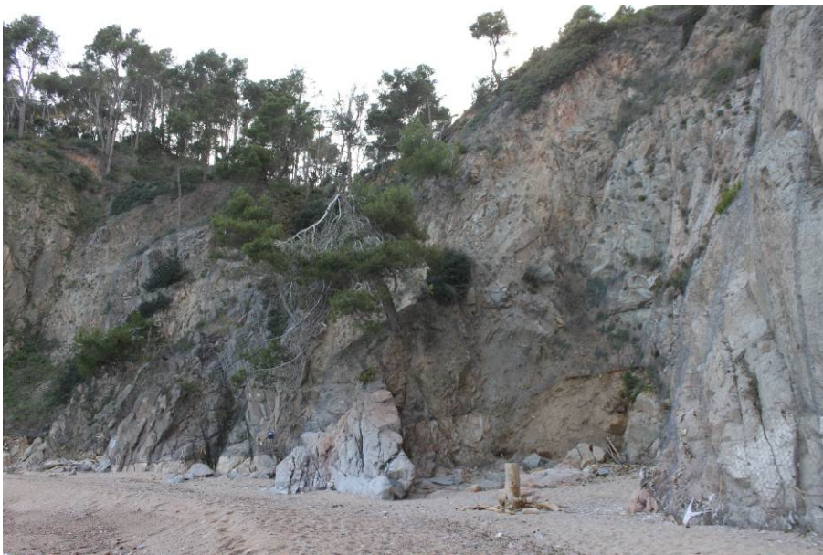
Fotografia 32. Vista parcial dels penyes-segats que envolten la platja del Golfet on s'observen alguns dels elements d'estabilització col·locats.
