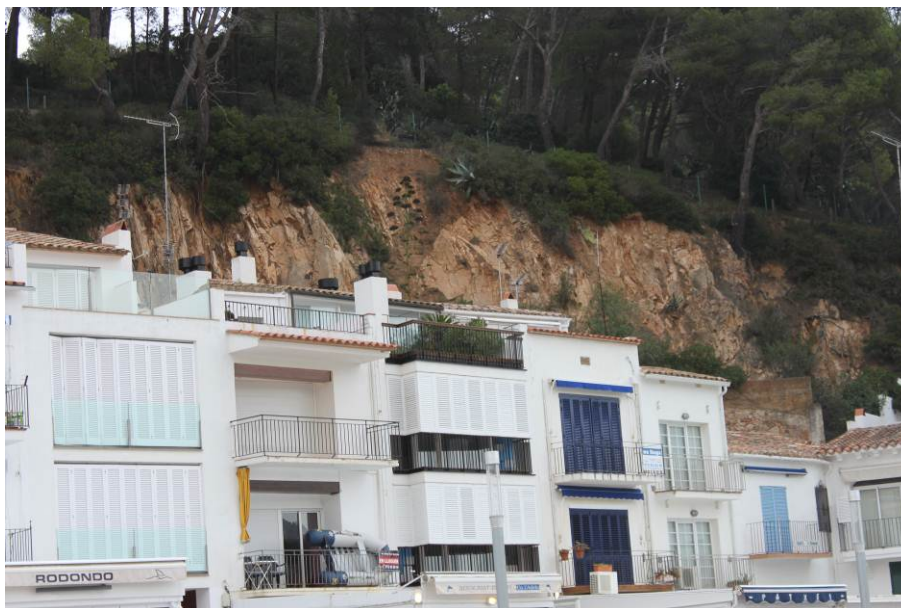
Fotografia 26. Paret de granit alterat i fracturat pel darrera de cases a la platja de Tamariu.
