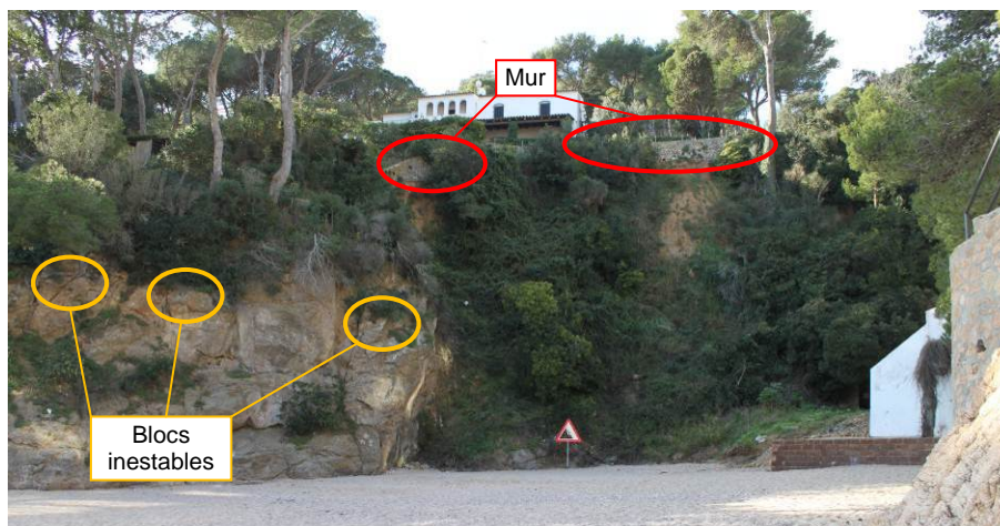
Fotografia 24. Platja dels Lliris. A l'esquerra una esllavissada senyalitzada amb el mur a la capçalera reparat. A l'esquerra la paret amb blocs inestables.
