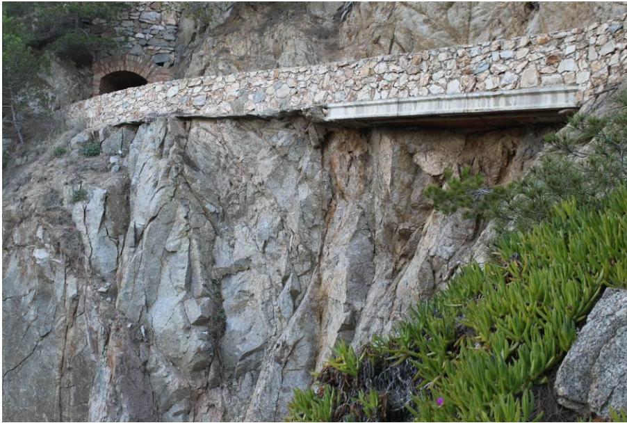
Fotografia 30. Descalçament del camí de ronda
